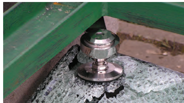
Obr. 7, 8: Příklady porušení skla
