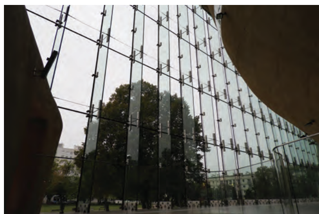
Obr. 3: – Příklad bodového upevnění skla
