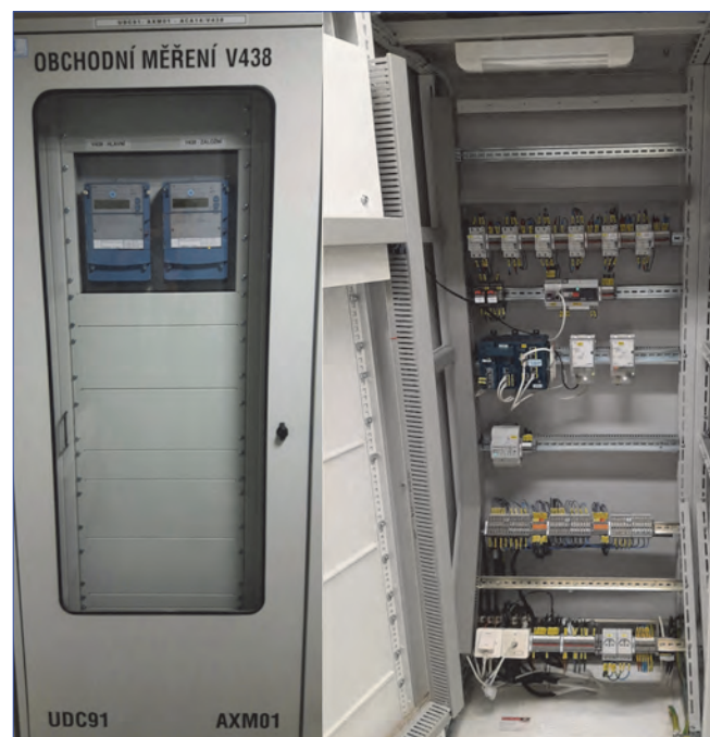
Obr. 8: Zařízení a vystrojení rozvaděčů OM
