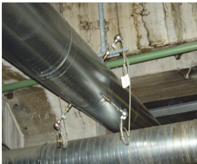
Obr. 3: Příklad realizace měření teploty podle doporučení v ČSN EN dodatku A1, kapitole A.7 (realizace v zahraničí)
