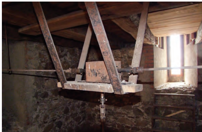
Obr. 9: Skříňka rozvodového soukolí
