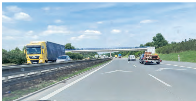
Obr. 6: V Česku i v dalších letech půjde bezpečnou vzdálenost mezi vozidly měřit jen s pomocí „obrácených věček“ na dálnicích
