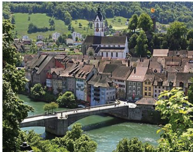
Obr. 4: Pod mostem na obrázku prochází hranice mezi německou a švýcarskou částí města Laufenburg
