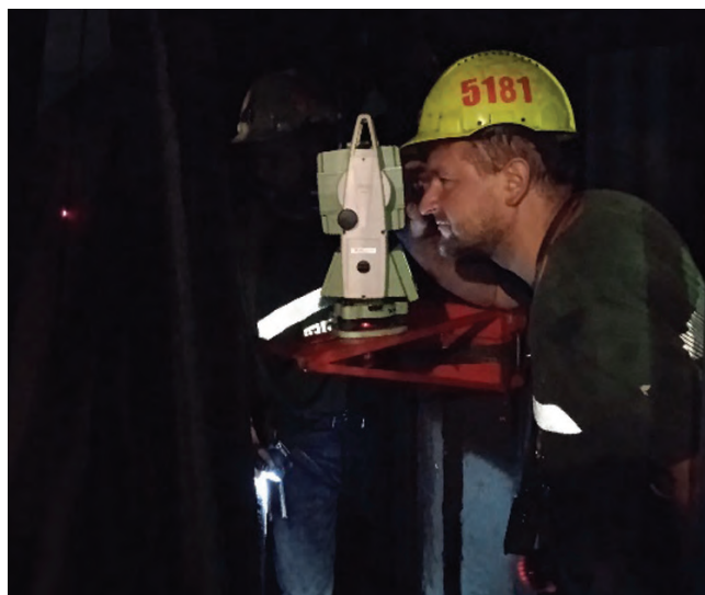
Obr. 4: Měření konvergence zdiva ve výdušné jámě ČSM Sever Zdroj: OKD
