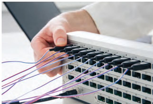
Obr. 3a: Termočlánky připojené k měřicí ústředně - drátové řešení
